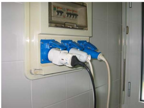
*Figura 6a, 6b: esempi di riduttori non conformi alle norme*
